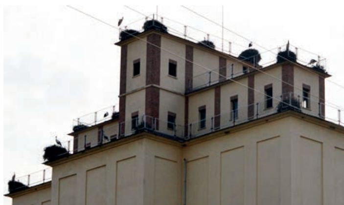
A les antigues sitges del Senpa al barri de Pardiñes a Lleida hi havia la colònia més gran de cigonyes en un edifici a Catalunya, que maleidament l'ajuntament el va enderrocar sense cap causa que el justificqués.
